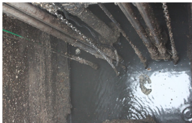
Levo je prikazan zbiralnik na enem od terenov, kjer smo preskusno namestili naš sistem, preden je bil nameščen sistem Flygt Concertor™, desno pa je zbiralnik po dveh tednih obratovanja našega sistema.
